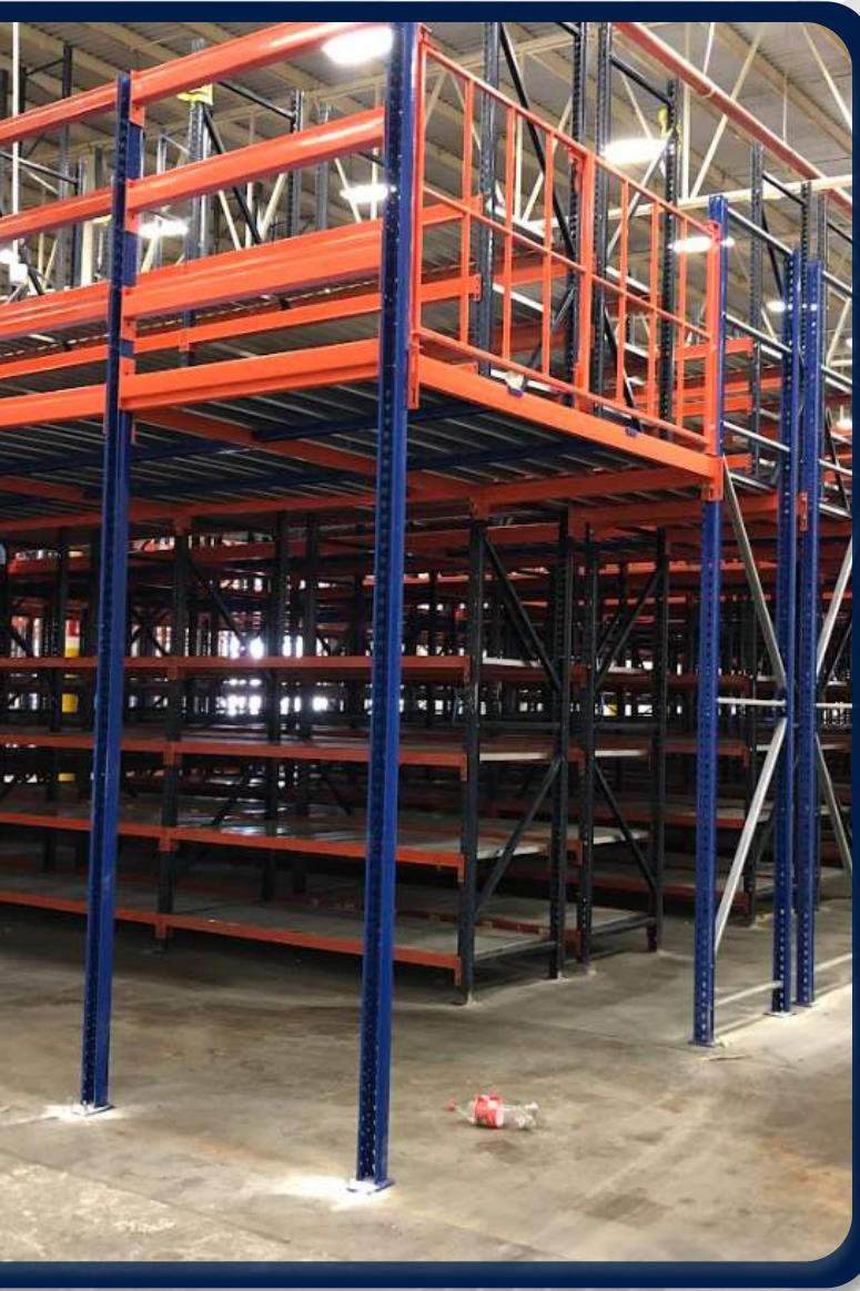
Este sistema consiste en niveles de piso sostenidos por la misma estructura del rack con el fin de aprovechar al máximo la altura de la bodega.
