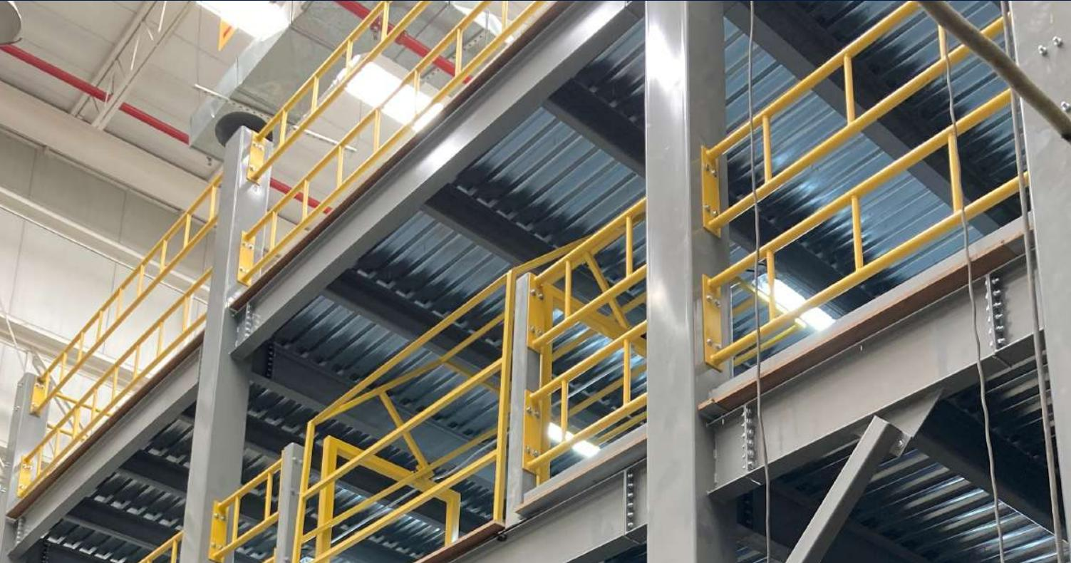
El mezzanine es un sistema que nos permite duplicar la superficie útil de una nave para disponer de más espacio, ya que aprovecha la altura máxima de la bodega. Este sistema puede ser combinado con cualquier otro de los sistemas por lo que se ampliarán las áreas de producción, áreas de almacenamiento o espacios de oficinas según sea la necesidad.
